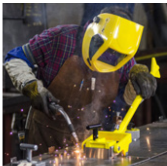
Стыковка и выравнивание
